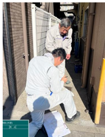
近隣の住宅の基礎や壁面に クラックがないか確かめる 作業員たち
