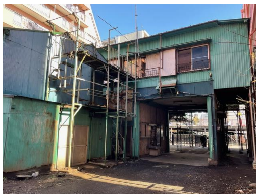
3月中に姿を消す既存の建物 いよいよ見納めです
